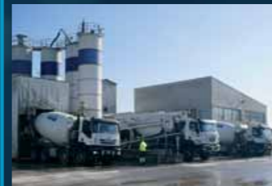
Installazione della centrale di betonaggio per la produzione e la vendita di calcestruzzo a Quinzano D'Oglio
