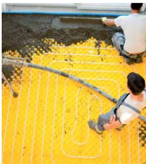
Massetto idoneo per realizzare pavimentazioni riscaldanti/raffrescanti mediante l'inserimento al suo interno di "serpentine" radianti.
