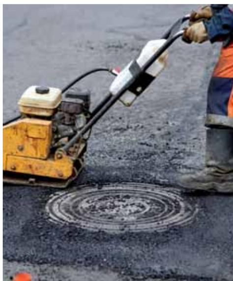
indicato per la manutenzione e riparazione di superfici stradali, per raccordare chiusini o piccoli dislivelli
