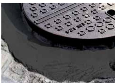
**FAST&FIBER** è una malta cementizia, fibrorinforzata, in classe R4 secondo la normativa EN 1504-3, a presa rapida, per il ripristino ed il rinforzo di strutture in calcestruzzo armato, contenente in sezioni separate aggregati silico-calcarei, cemento Portland, aggiunte minerali, fibre polimeriche per il contrasto di eventuali formazioni di cavillature superficiali e additivi atti a migliorare le caratteristiche reologiche del prodotto.
