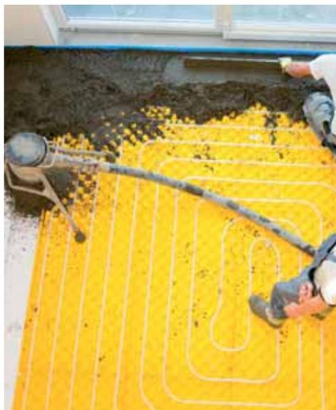
Con CT25DRY è possibile realizzare pavimentazioni riscaldanti/raffrescanti mediante l'inserimento al suo interno di "serpentine" radianti.
