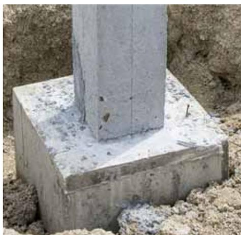
**COLA&RINFORZA** è una malta cementizia monocomponente colabile, fibrorinforzata, ad elevata stabilità volumetrica, di classe R4 secondo la normativa EN 1504-3, per la realizzazione di ripristini strutturali di strutture in calcestruzzo armato, per il risanamento del calcestruzzo ammalorato; inoltre, il prodotto soddisfa i requisiti della EN 1504-6.
