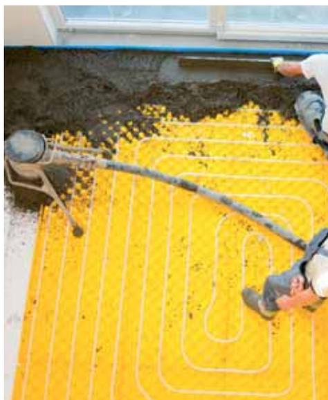
Con CT20 FIBER è possibile realizzare pavimentazioni riscaldanti/raffrescanti mediante l'inserimento al suo interno di "serpentine" radianti.
