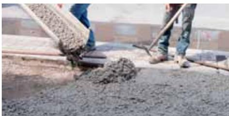
MISTO NATURALE DA GETTO 0/12 è indicato per la formazione di calcestruzzi strutturali e la produzione di calcestruzzi utilizzati in opere di ingegneria civile e nella costruzione di strade.
