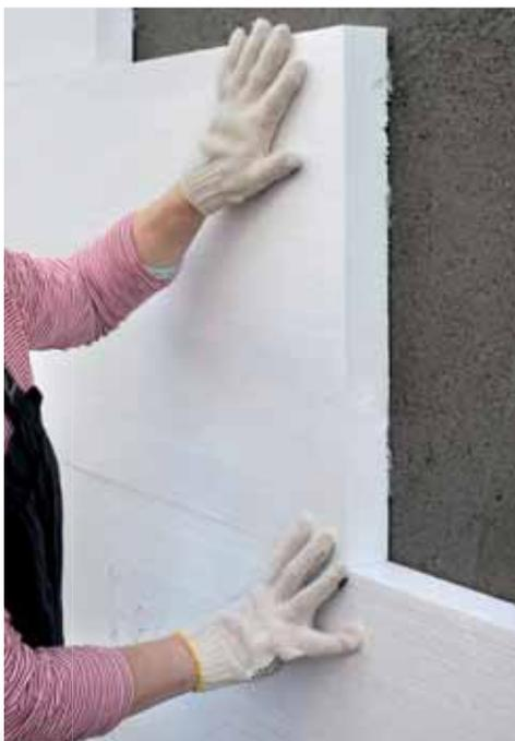
RASACEMG è indicato per incollare e rasare pannelli isolanti per sistemi a cappotto nonché per l'esecuzione di rasature senza e con rete d'armatura in fibra di vetro.
