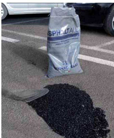
Indicato per la manutenzione e riparazione di pavimentazioni stradali con traffico veicolare continuo.
