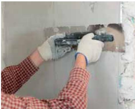
RASAGYPS FAST- SCAGLIOLA è un prodotto di finitura per interni applicabile su qualsiasi tipo di intonaco di fondo a base gesso o calce/cemento.
