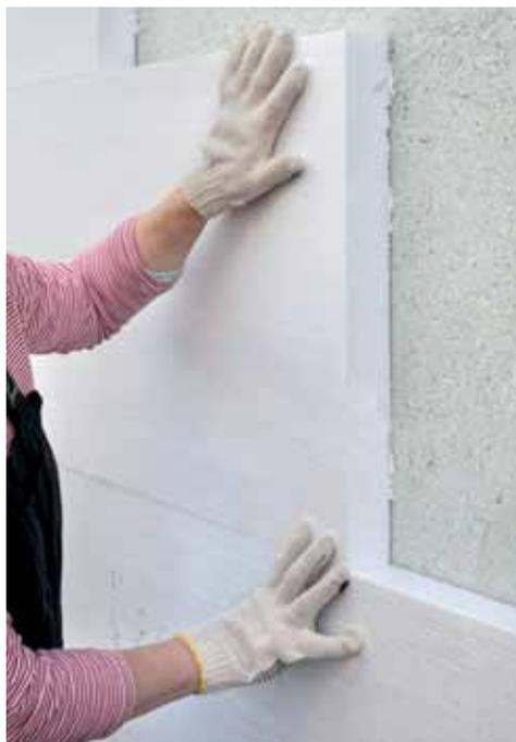
RASACEMB è indicato per incollare e rasare pannelli isolanti per sistemi a cappotto nonché per l'esecuzione di rasature senza e con rete d'armatura in fibra di vetro.
