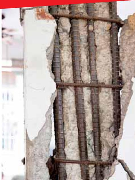
**PASSIVANTE** è una malta cementizia monocomponente anticorrosiva a base di leganti cementizi, resine sintetiche, microsilici e speciali additivi inibitori della corrosione. **PASSIVANTE** è una malta appositamente studiata per la protezione dei ferri d'armatura per prevenire e contrastare la formazione di ruggine, specifica per il ripristino del cemento armato strutturale e non strutturale.
