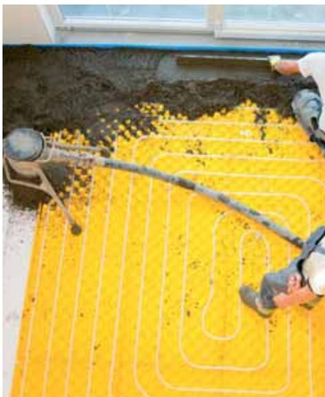
Con CT20 è possibile realizzare pavimentazioni riscaldanti/raffrescanti mediante l'inserimento al suo interno di "serpentine" radianti.
