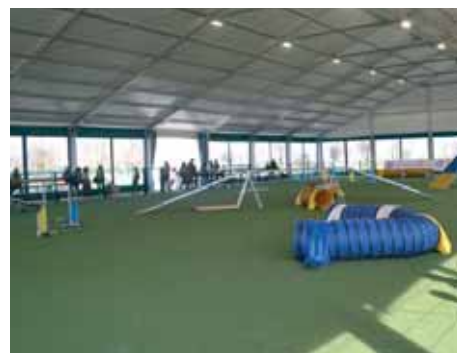
Realizzazione di pavimentazione in un centro cinofilo.
